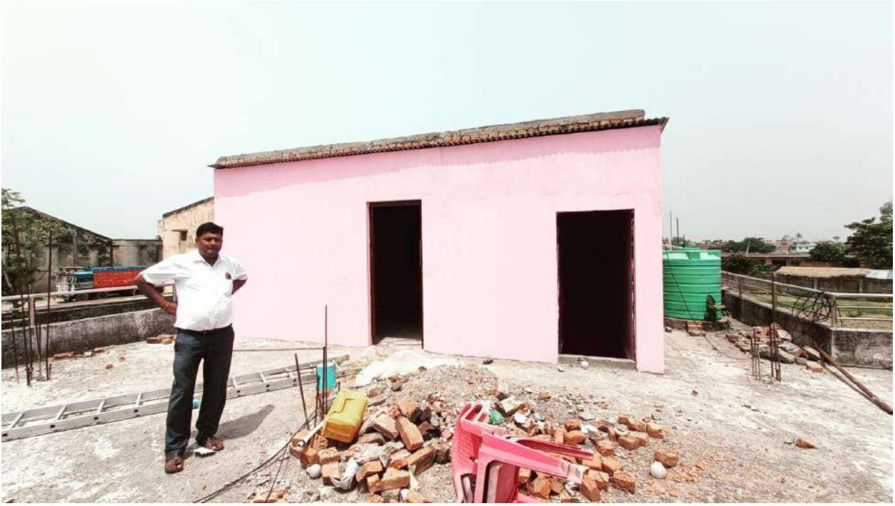
वडा कार्यालय भवन वडा नं ४ चैनपुर
